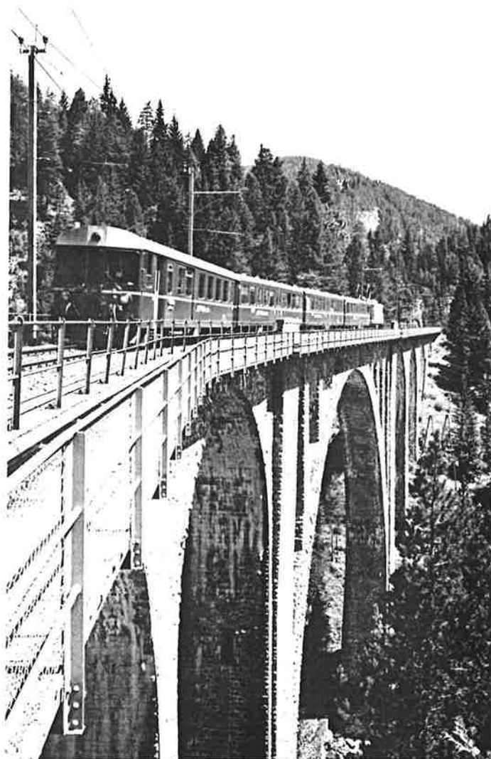
Le viaduc de Wiesen entre Davos et Filisur.
